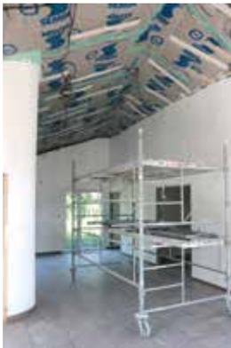
Les maisons individuelles et le bâtiment principal, hors d'eau et hors d'air, voient les aménagements intérieurs et extérieurs avancer chaque jour. Les principaux raccordements (eau, électricité, gaz) ont été effectués, la pose des sols, des plafonds et de l'escalier (dans le bâtiment principal) ainsi que les enduits et bardages extérieurs se terminent.
