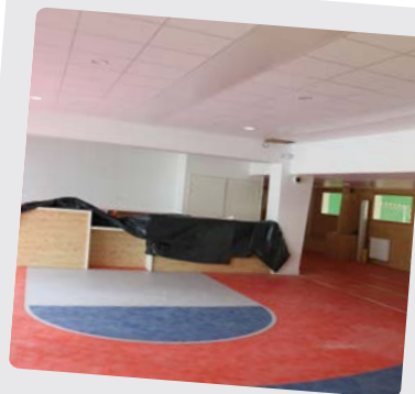
Travaux du Hall du Complexe sportif de la Guerche
