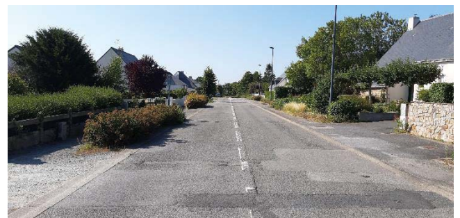
Aménagement existant rue de la Chézine
