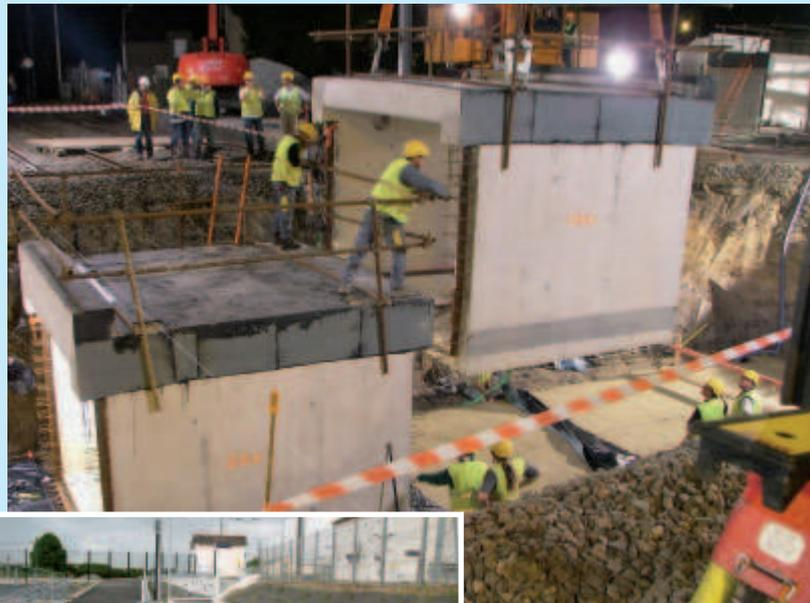
La pose des caissons en béton pour réaliser le souterrain avait nécessité 24 h en septembre 2008.
