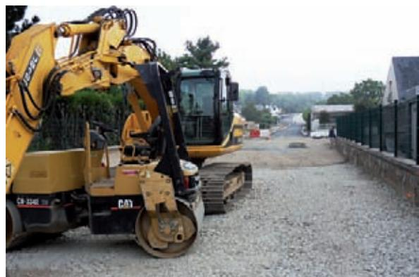
Réalisation de la structure de la chaussée après décaissement de l'ancienne route.
