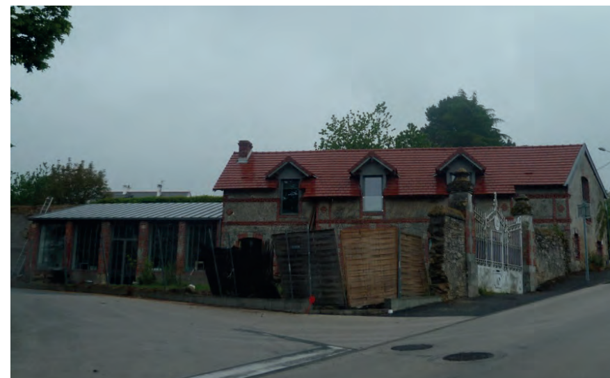
- Exemple de réhabilitation d'une maison à Saint-Etienne-de-Montluc -
