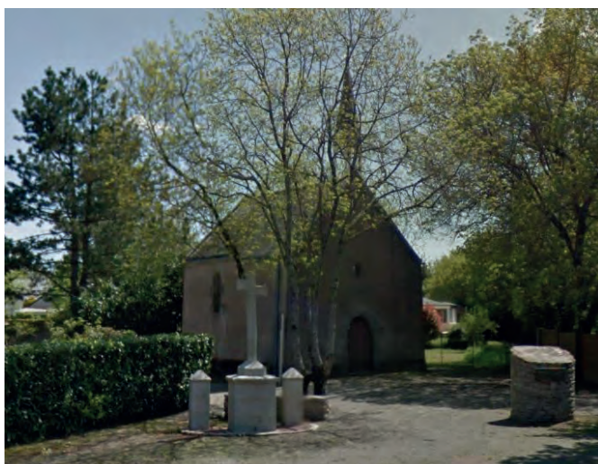
Chapelle Notre Dame de Toutes Vertues, située dans le bourg et accessible au public. Le Temple-de-Bretagne
