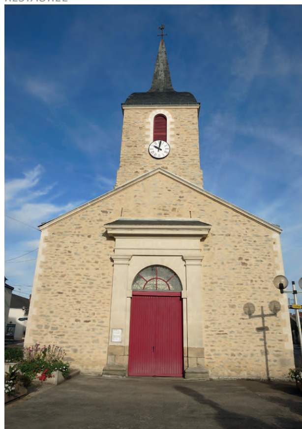
ÉGLISE DU TEMPLE-DE-BRETAGNE RÉCEMMENT RESTAURÉE
