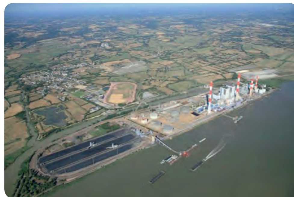
- Le site de la centrale thermique de Cordemais aujourd'hui -
