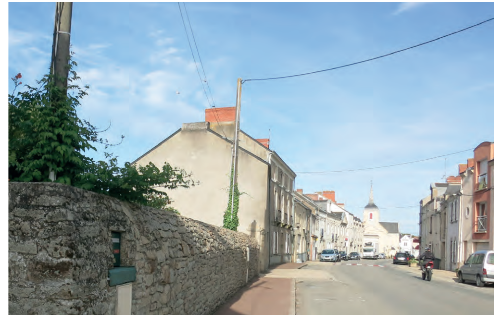
- Maison de bourg en enfilades, dont les hauteurs homogènes apportent une fluidité à la rue et cadrent le regard sur l'église, au gabarit plus important.
