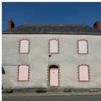
Façade d'une maison de Cordemais, rue de la Loire, présentant des encadrements en brique cintrés.
