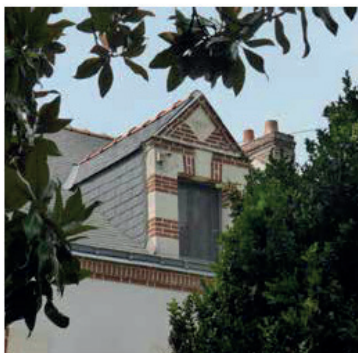
Motif de brique et tuffeau ornant la lucarne d'une maison près du hameau du Héraut à Saint-Etienne-de-Montluc
