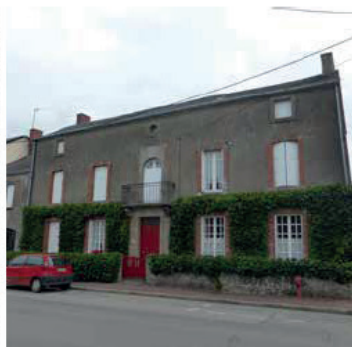
Maison de maître à côté de laquelle se situe la serre (photo à gauche), elle présente des encadrements de brique.
