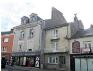
MAISON DE BOURG À HAUTEUR DIVERSES, EN DÉCROCHÉE - BOURG DE ST ETIENNE-DE-MONTLUC
